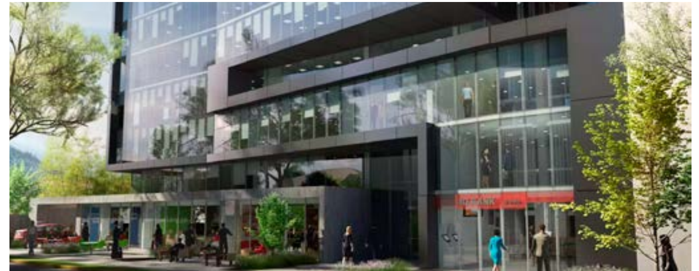
EDIFICIO NUCLEO Providencia
